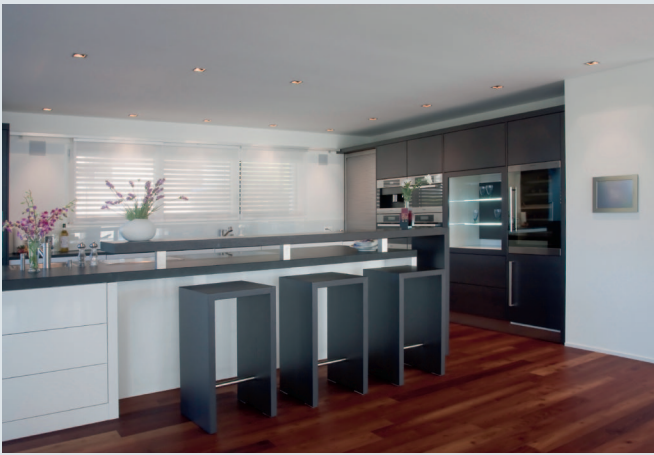
Unsichtbare Technik: In der Decke eingebaute Lautsprecher und das an der Wand untergebrachte Touchpanel für die Steuerung des Netzwerks.
